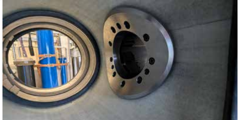
Abb. 42: Dichtelement montiert im Seitenabgang
